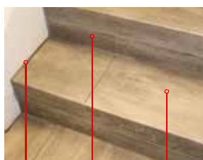
Mit Silikonfuge Setzstufe (Stirnseite) im gleichen Dekor mit Versatz Trittstufe mit Stoß
