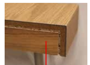
Stirnseite bei freistehender Treppe mit Klebefliese bzw. Holz-Deckschicht kaschiert.
